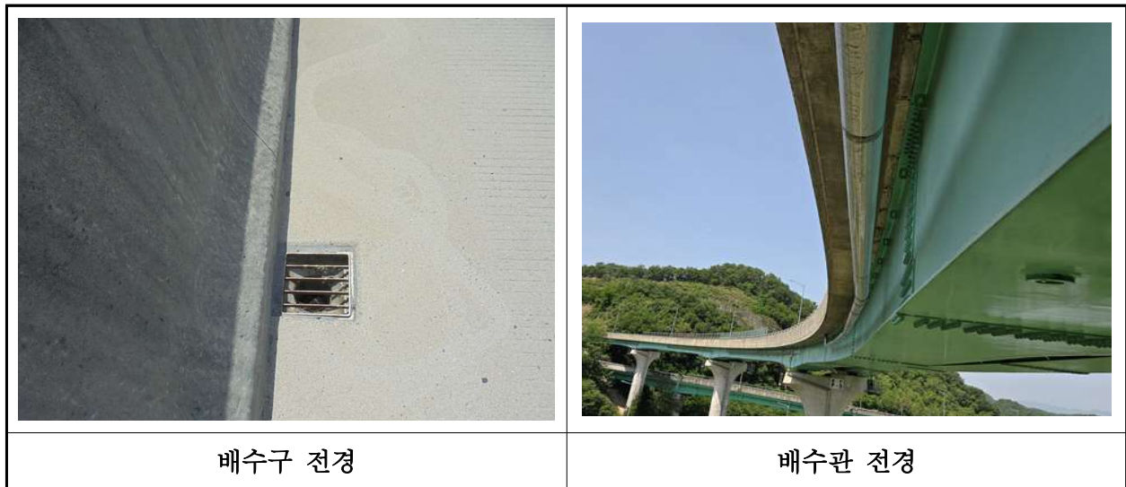
【사진 34.3.22】 배수시설 전경
