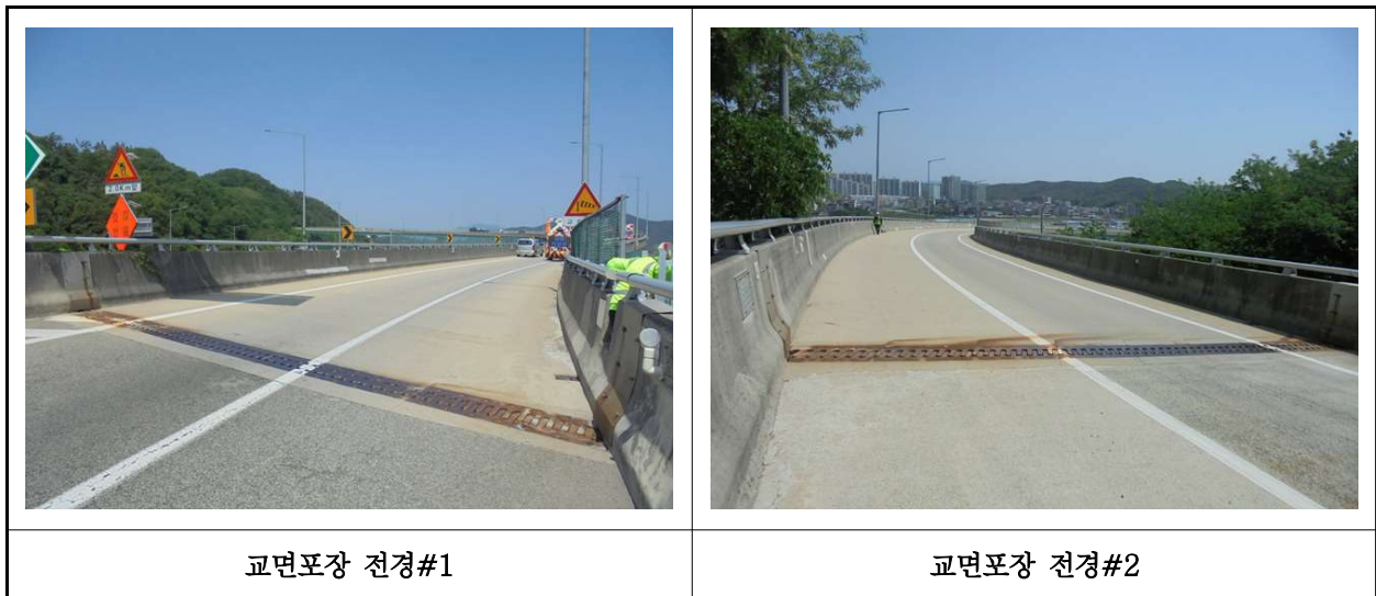
【사진 34.3.20】 교면포장 전경
