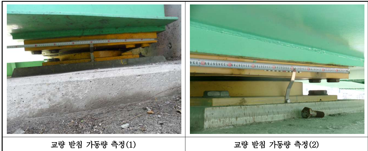
【사진 34.3.16】 교량받침 이동량 측정
