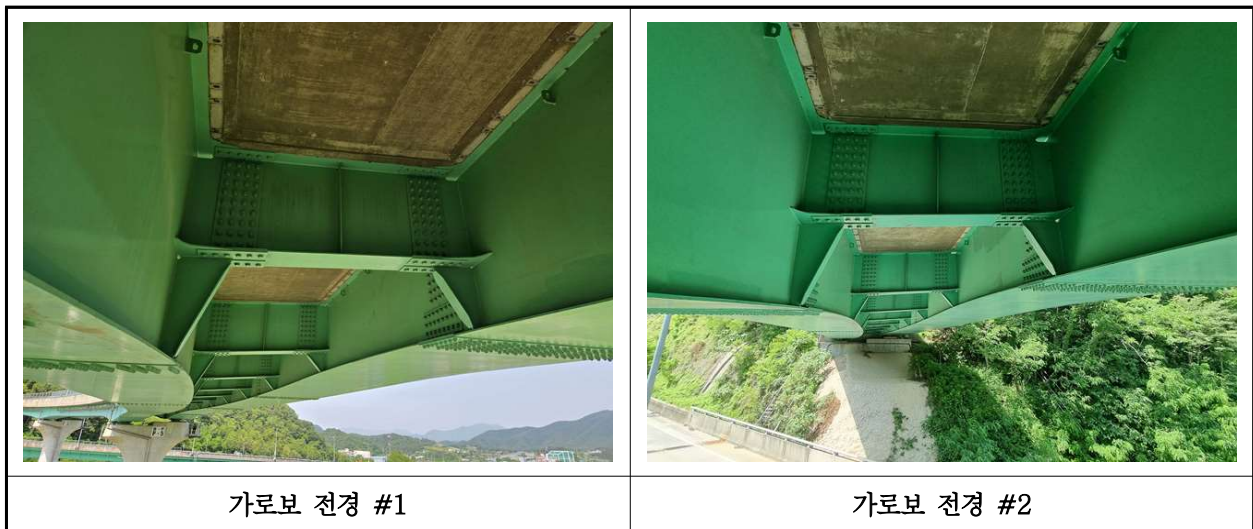
【사진 34.3.6】 가로보 전경
